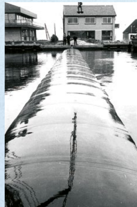
De balgstuw in Oude Wetering. (foto: Co en Liza Warmerdam)
